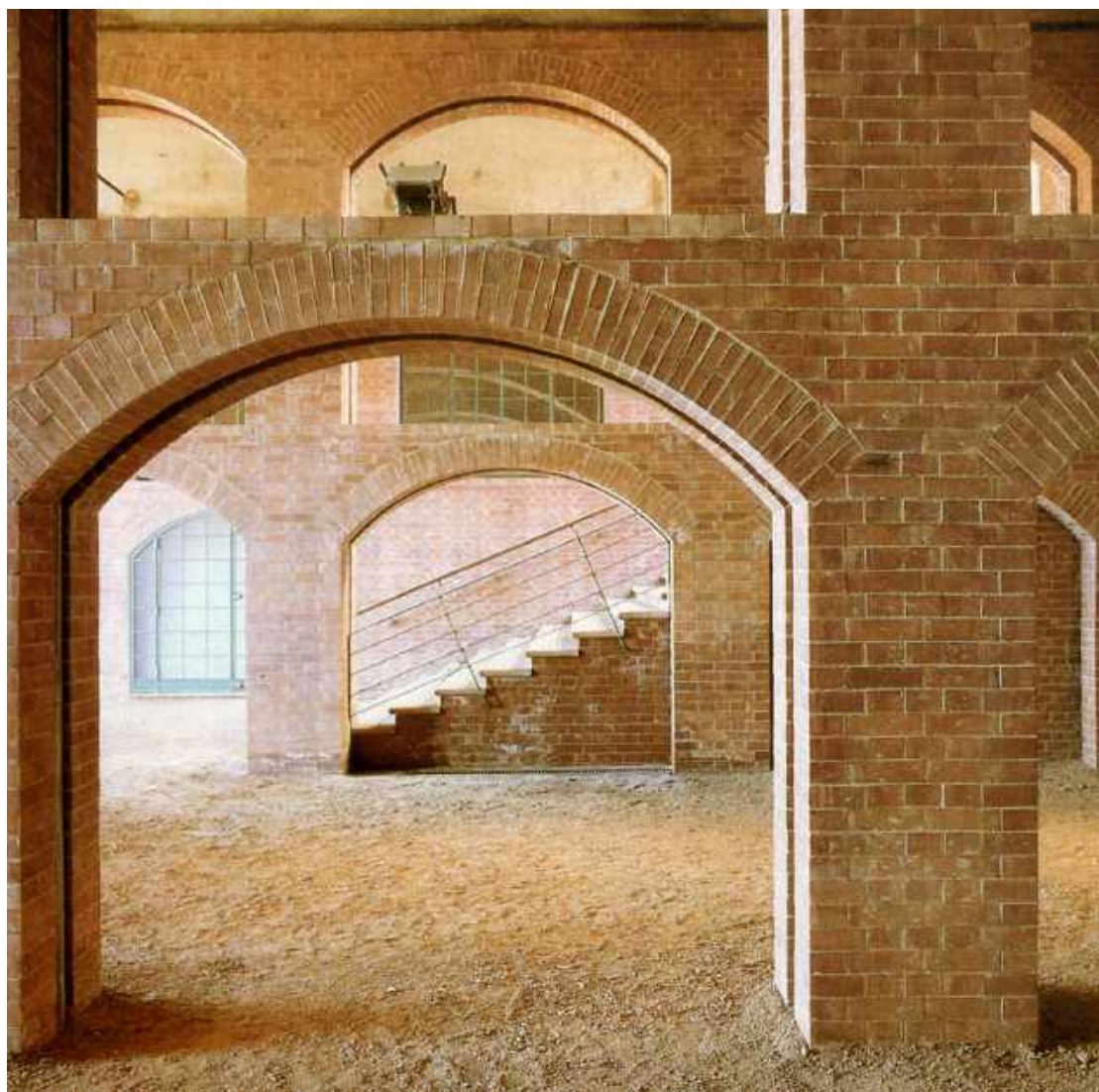
Vistas de los arcos porticados diáfanos con el «pavimentado» original de guijarros de ladrillo molido. Foto: Revista «ON», nº 98, 1988
