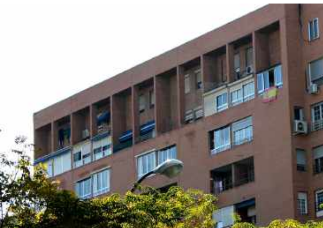
Vista de las viviendas, en «duplex», en el estado actual con los cerramientos incorporados por los usuarios. Foto: GHU
