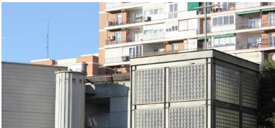
Remate del edificio, en la zona opuesta al acceso, con el volumen de pavés, cilindro del ascensor y prisma de la escalera. Foto: GHU
