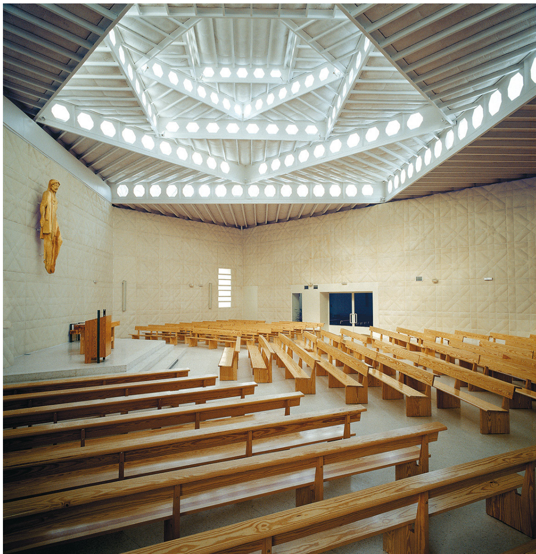
Vista del interior de la iglesia con las vigas armadas de la «cúpula» de cerramiento superior
